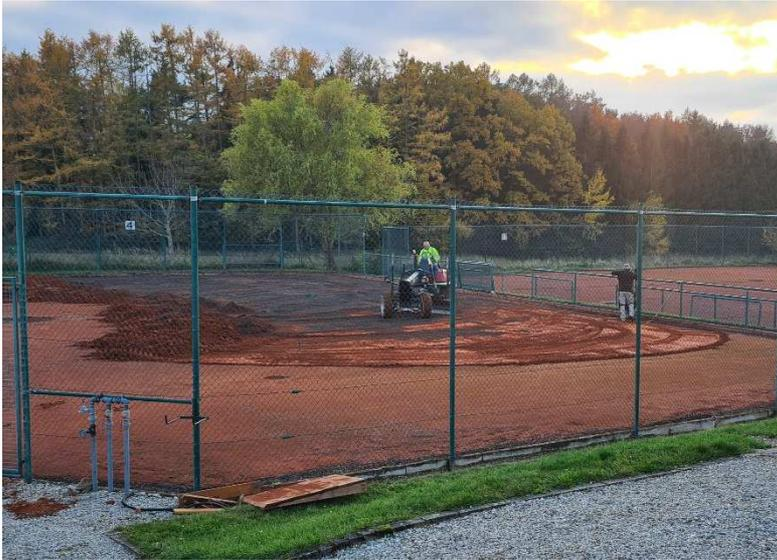
Losgelegt wurde am 05.11.2020 mit einem lasergesteuerten High-Tech-Grader der im ersten Stepp die Ziegelschicht abschabte und im zweiten Stepp die darunterliegende Vulkan-Gestein-Schicht millimetergenau auf die neuen Vorgaben der Fa. Sportas einrichtet.
